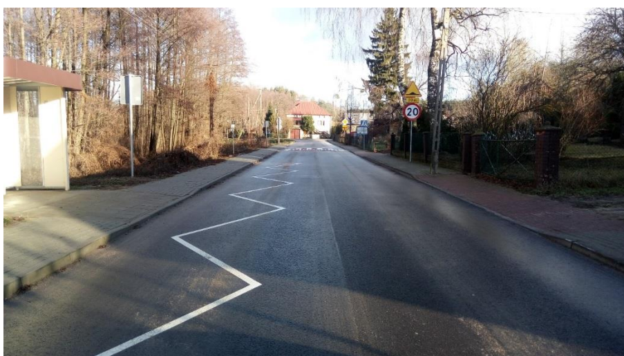
Rysunek 21 Droga powiatowa nr 1416B Mońki – Hornostaje – Goniądz. Nawierzchnia bitumiczna wraz z elementami bezpieczeństwa ruchu drogowego (próg zwalniający) w m. Hornostaje
