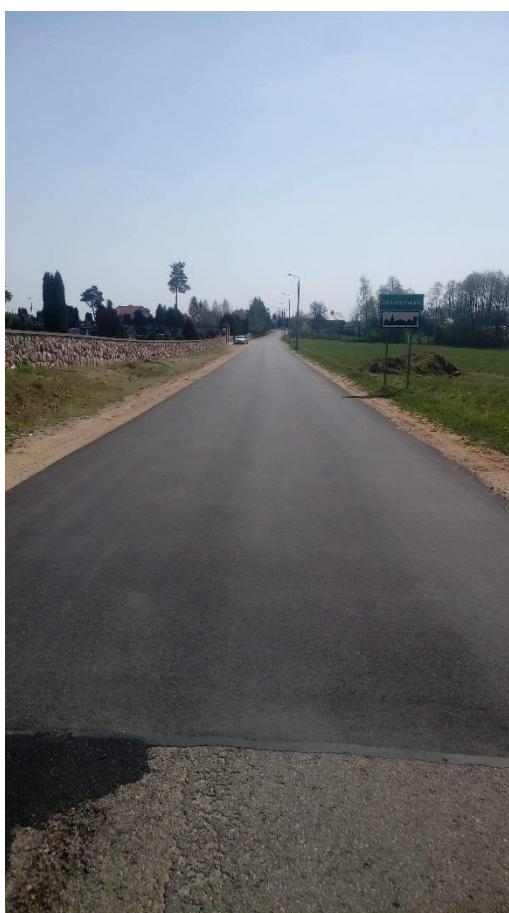
Rysunek 30 Droga powiatowa nr 1355B Starowola – Koziniec – Słomianka – Jasionówka. Odcinek w kierunku DW nr 671. Nowa nawierzchnia bitumiczna wraz z poboczami z kruszywa naturalnego
