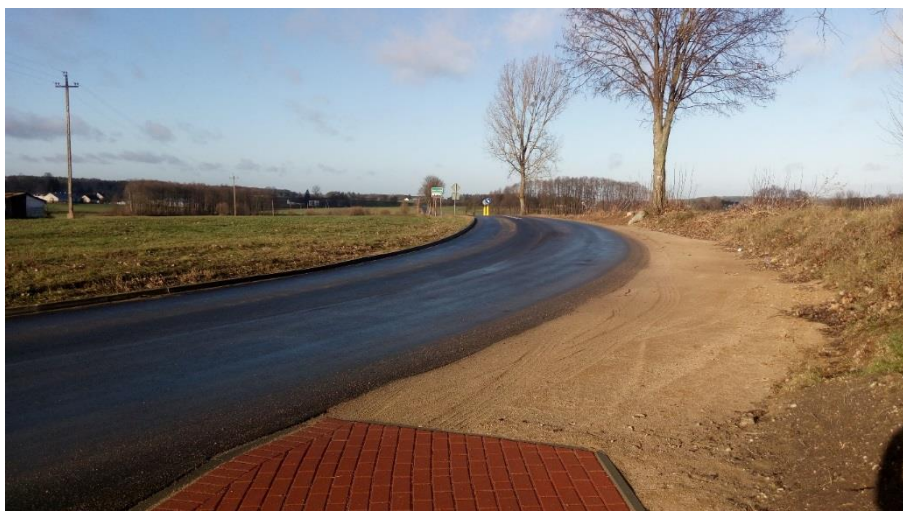
Rysunek 20 Droga powiatowa nr 1416B Mońki – Hornostaje – Goniądz. Nowa nawierzchnia bitumiczna wraz z poboczami z kruszywa naturalnego za m. Hornostaje
