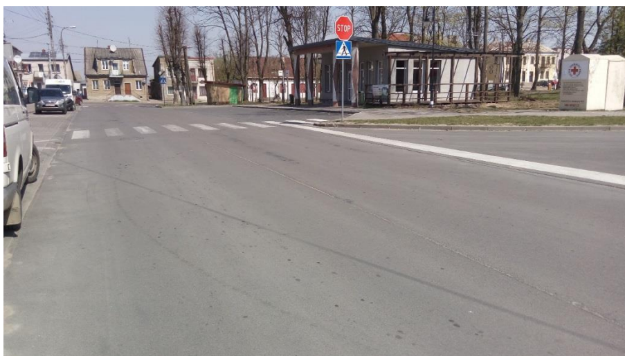
Rysunek 27 Droga powiatowa nr 2629B ul. Plac 11 Listopada w Goniądzu. Nowa nawierzchnia bitumiczna wraz z oznakowaniem poziomym.
