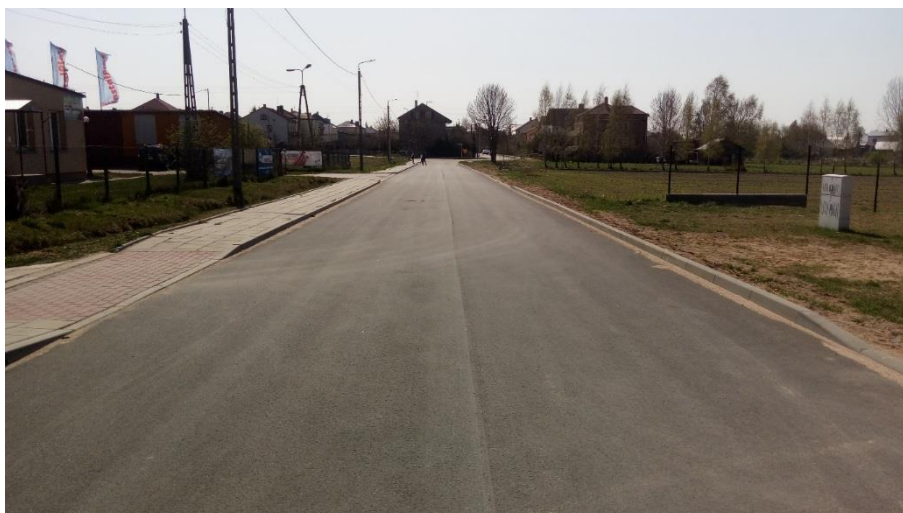
Rysunek 29 . Droga powiatowa nr 2342B ul. Władysława Jagiełły w Knyszynie. Nowa nawierzchnia bitumiczna wraz z krawężnikiem betonowym.
