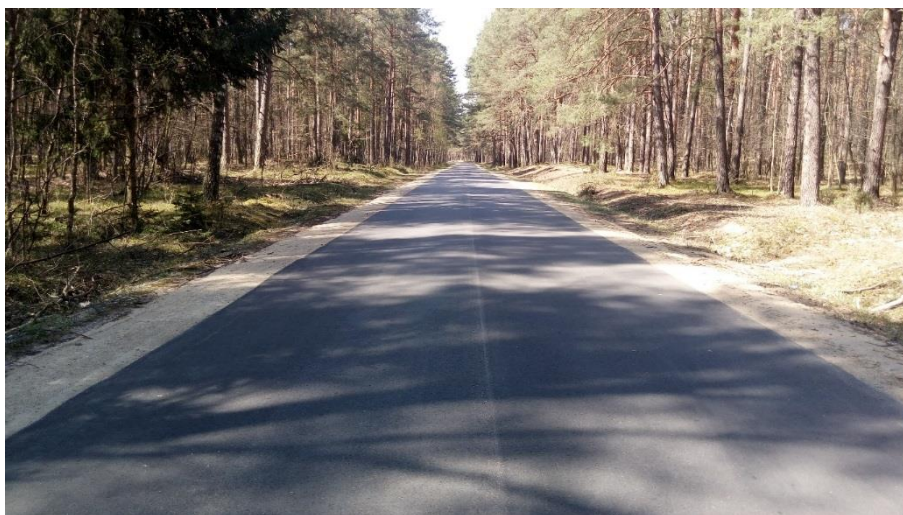
Rysunek 26 Droga powiatowa nr 1842B Trzcianne – dr. pow. nr 1838B /Gugny/. Nowa nawierzchnia bitumiczna wraz z poboczami z kruszywa naturalnego.
